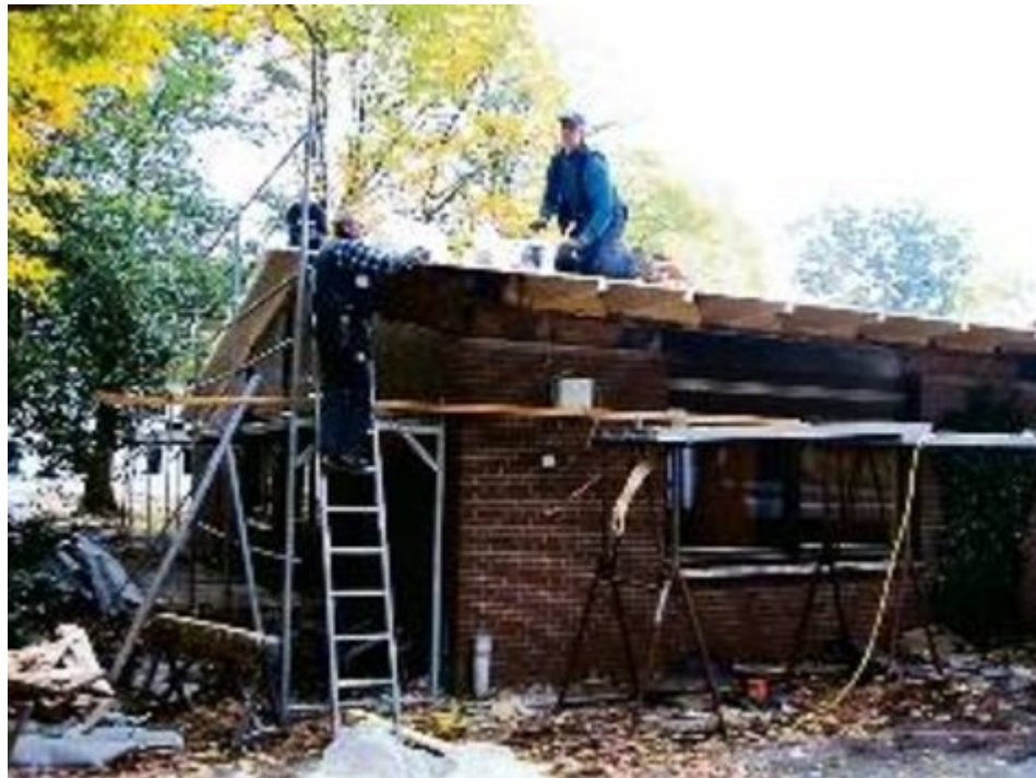
Das Dorfgemeinschaftshaus Clüversborstel erhielt jetzt eine neues Dach. Auch die darunter liegende Elektroinstallation wurde erneuert.
