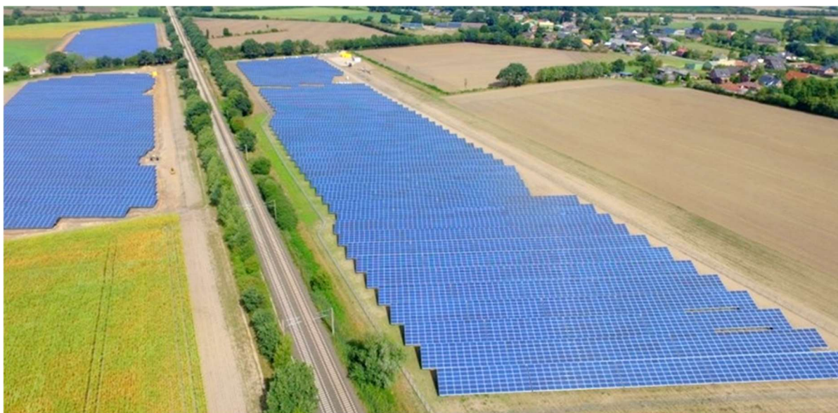
Abbildung 5: Beispiel desselben Vorhabenträgers für eine Photovoltaik-Freiflächenanlage in Ellerdorf (Quelle: SolarWind Projekt GmbH, Hamburg) s.o
